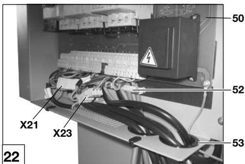
**!** Über die Sicherung darf kein zusätzlicher Verbraucher geführt werden, da sonst die max. Stromaufnahme überschritten wird.
